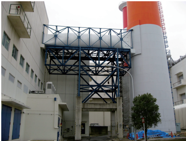
▲主排気筒ダクトの外観（右側が主排気筒）
