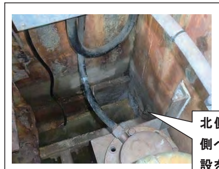
ASW ストレーナエリア側 へコンクリート 打設を実施
