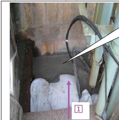
ケーブルピット 廻りへコンクリ ート打設を実施
