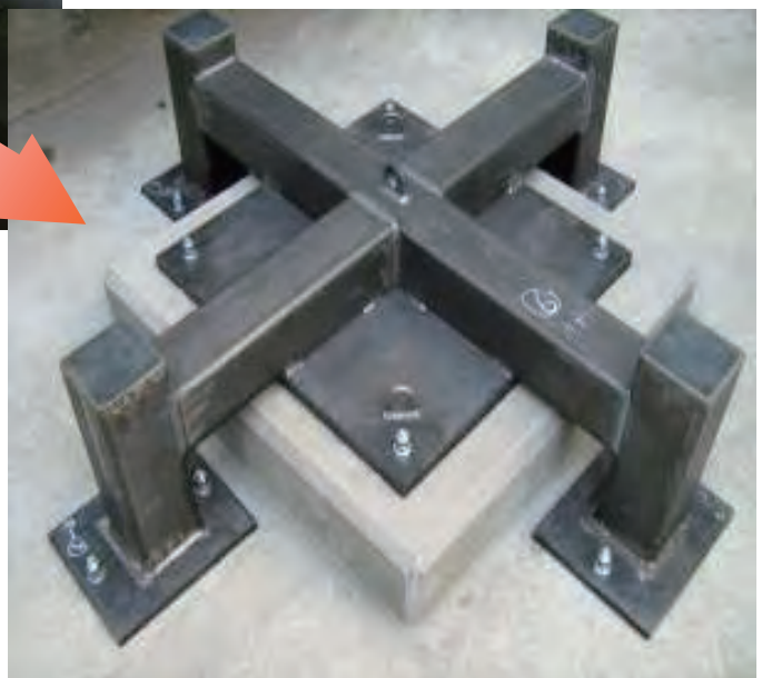
水位計収納箱を取り外し、閉止板を取り付け（対策後）
