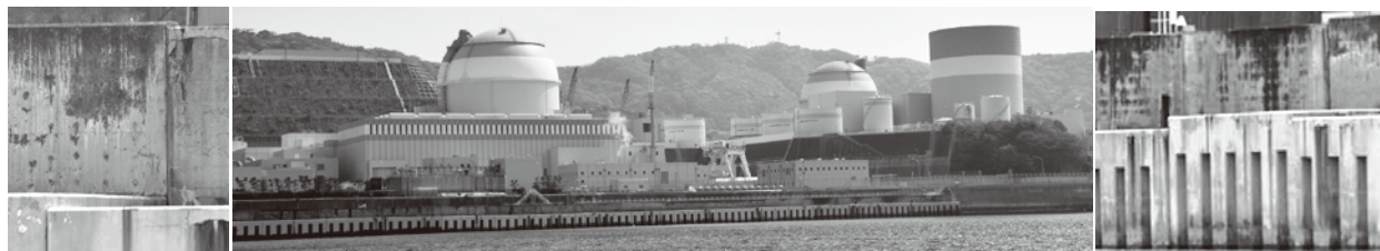
伊方原発 水深 18m、22m 高の盛土工事により築いた岸壁は至る所で不等沈下を起こしている。 2020 年撮影 ©N.O.
