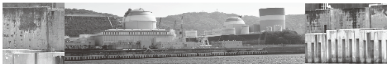
伊方原発 水深 18m、22m 高の盛土工事により崩れた岸壁は至る所で不等沈下を起こしている。 2020 年撮影 ©N.O.
