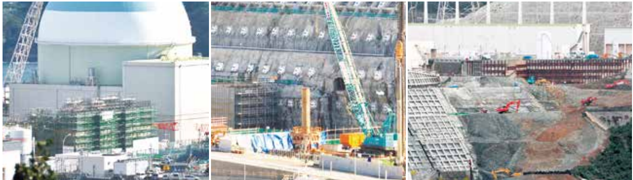
▲2018年10月27日伊方原発3号機起動。3号機に隣接する建設工事は未完。脆い斜面の土木工事も未完。10/27撮影
